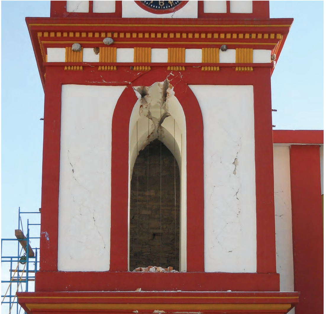
· Trabajos de consolidación en torre y arcos de campanario. Templo de Santiago Apóstol, Santiago del Río, Silacayoápan, Oaxaca. Fotos: Centro INAH-Oaxaca.
