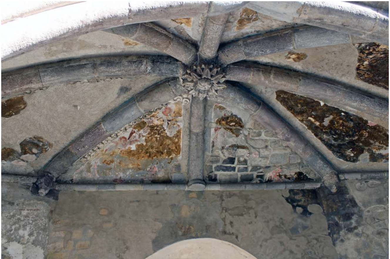
Bóveda Nervada de la Capilla abierta del Ex Convento Franciscano de Nuestra Señora de la Asunción, 2019. Tlaxcala, Tlaxcala.
