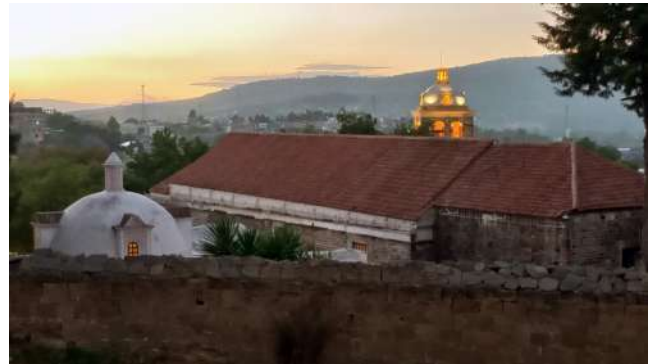
Cubierta a dos aguas de la nave principal, torre exenta y cúpula de capilla de la tercera orden, 2024. Fotografía: Andrea Herrera González.
